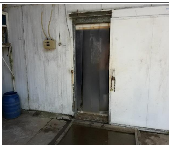
Dia 31/8/2017 – prédio do Dnocs: câmara fria antiga com pouca proteção.
