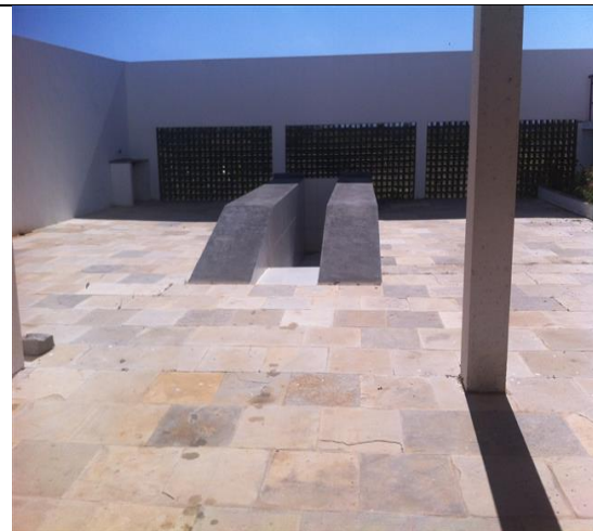
Local para a limpeza das ambulâncias
