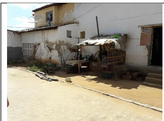
Dia 31/8/2017 – prédio do Dnocs: moradores no local.
