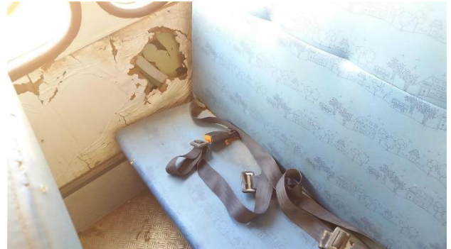
Foto 16: Veículo de placa PEX 7201: Estrutura interna da carroceria em avançado estágio de deterioração; Serra Talhada/PE, 30 de agosto de 2017.
