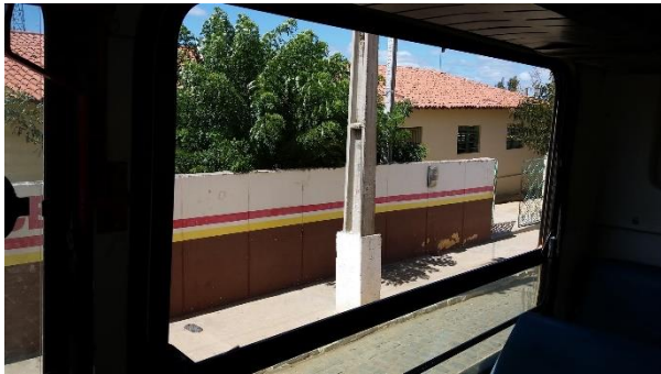
Foto 23: Veículo de placa PGG 3373: Janela sem vidro, oferecendo perigo de os estudantes serem arremessados para fora do veículo em caso de colisões e manobras bruscas; Serra Talhada/PE, 31 de agosto de 2017.
